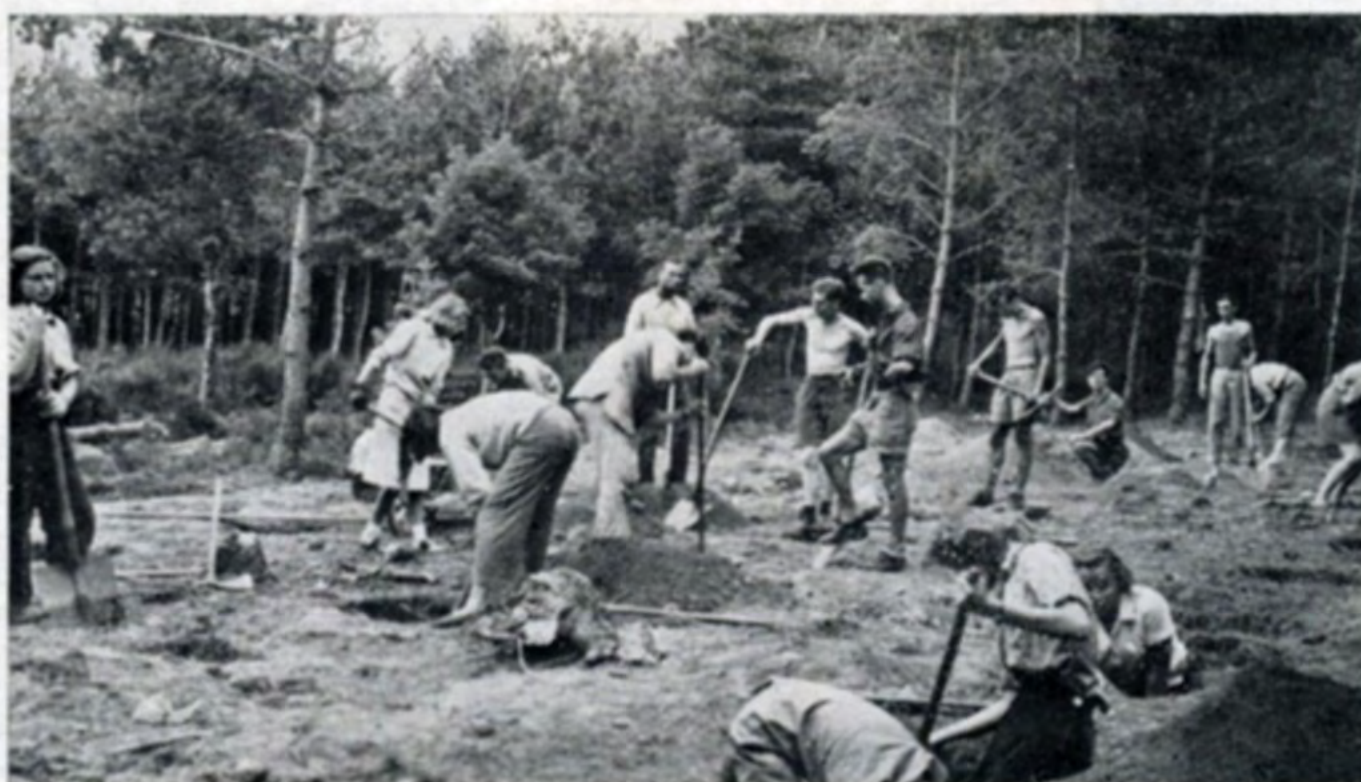
Première semaine on creuse les fondations
