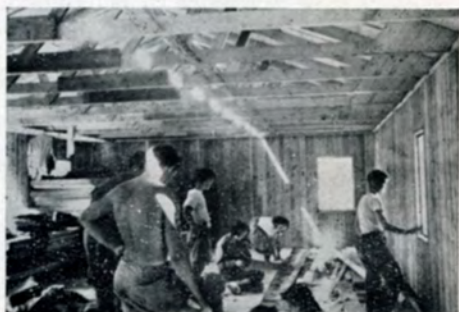
On pose le plancher de la Bonkoja
